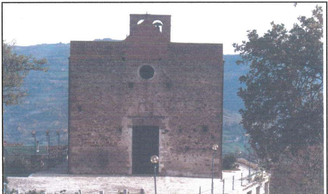
Chiesa di S. Maria - facciata nord-ovest
